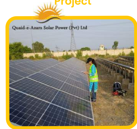
100kW Grid Tie Solar
